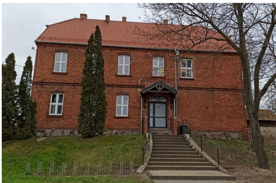
Rycina 13 Budynek dawnej szkoły we Włóściejewkach
